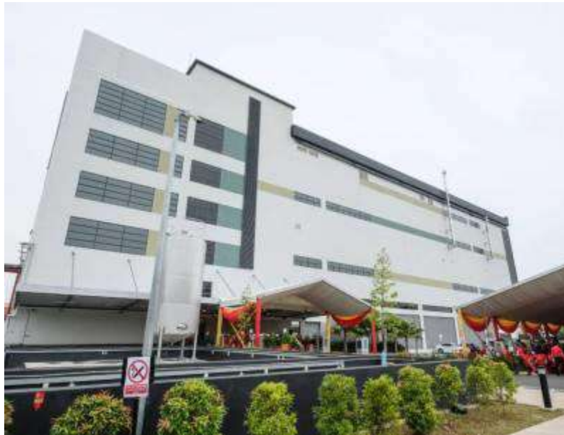
Neue Matrix Fabrikanlage in Kuala
